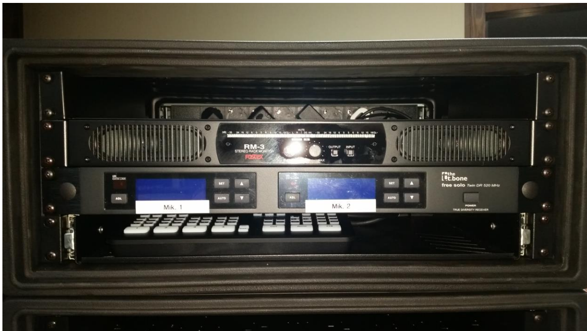
Abb. 10: Wenn der drahtlose Doppelpfänger eingesetzt, wird der Empfänger zunächst auf der Rückseite mit Spezialkabeln (XLR-w auf Mini-Klinke stereo) mit den beiden Mikrofoneingängen des Videomischpultes verbunden. Der Lautsprecher-Einschub (Fostex RM 3) sollte erst nach Verkabelung des Doppelpfängers eingebaut werden. So wird die Verkabelung im engen Rackgehäuse erleichtert.
