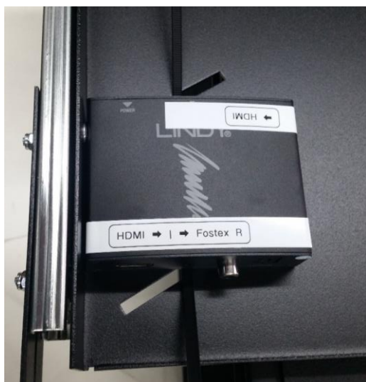
Abb. 5: Bevor der Rackauszug in das Rack eingebaut werden kann, muss zunächst hinten rechts (von vorn gesehen) auf dem Auszug das Verteilerkästchen zur Gewinnung des Kopfhörerausgangs aus dem HDMI-Signal des Videomischpultes montiert werden. Das geht am besten mit einem langen Kabelbinder, der durch die im Boden des Auszugs befindlichen Öffnungen gezogen wird. Das Kästchen sollte vor dem Einbau beschriftet werden (HDMI in, oben; HDMI out und Mini-Klinken-Ausgang zum Eingang des Lautsprecher-Einschubes Fostex RM 3 auf Rechts, unten).
