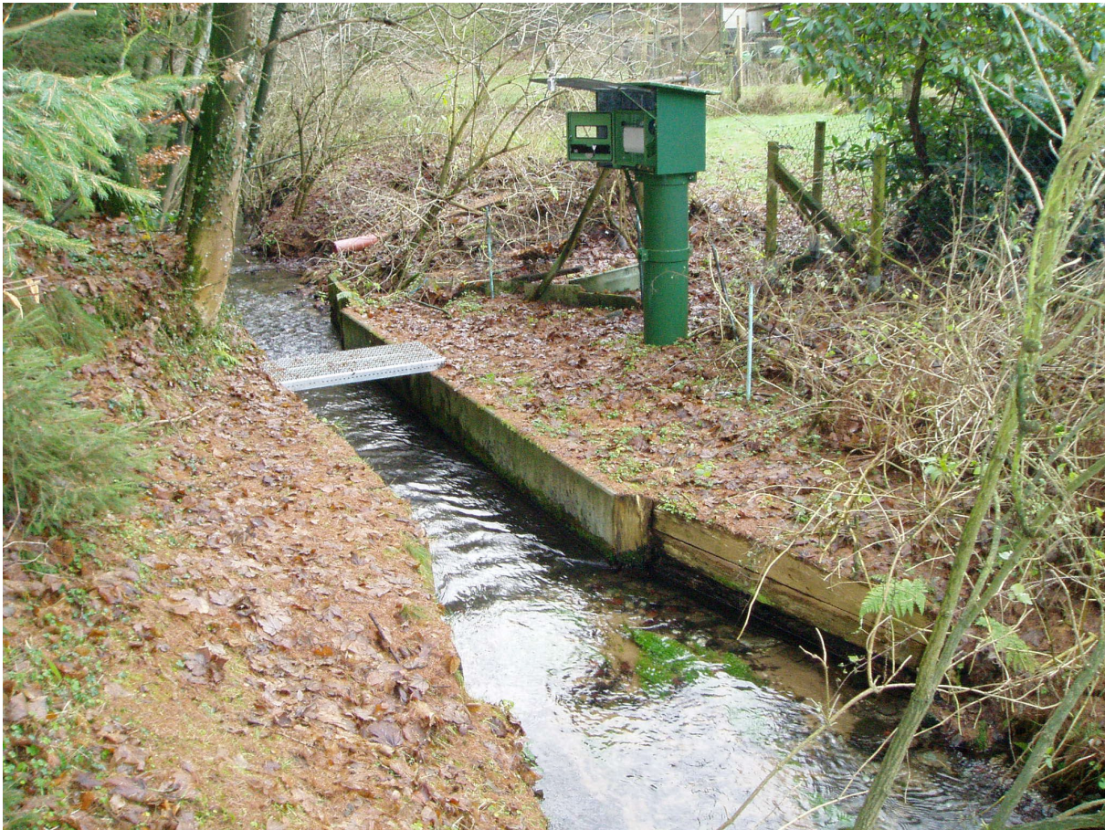
Bild 1 Die Pegelanlage Bokelmeier / Ölbach unterhalb der Fischzuchtanlage Lindhorst-Emme
