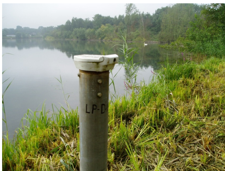
Bild 3: Grundwasser-Messstelle LP-16 der Firma Duro-Ideal Abgrabungen am Mühlensee in Bentfeld
