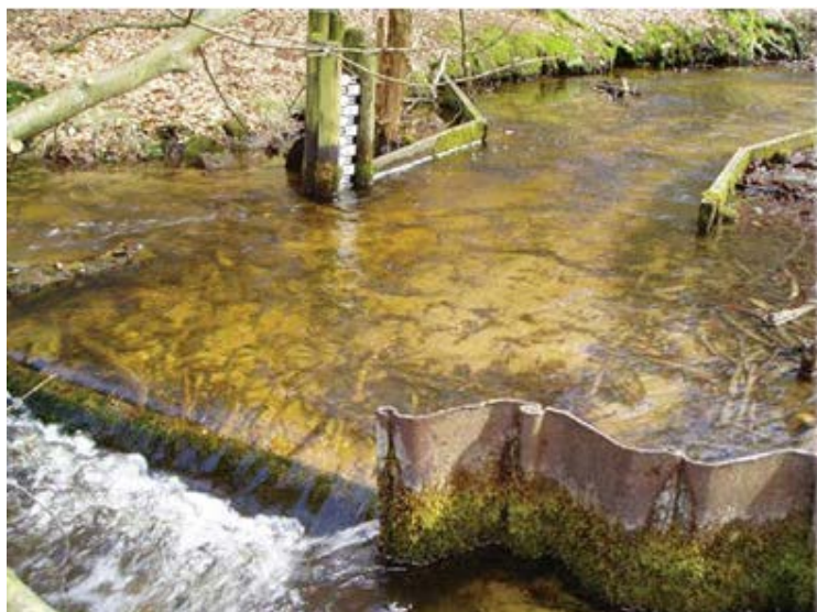
Bild 3 Die Pegelanlage Donoper Teich / Hasselbach vor den Umbaumaßnahmen
