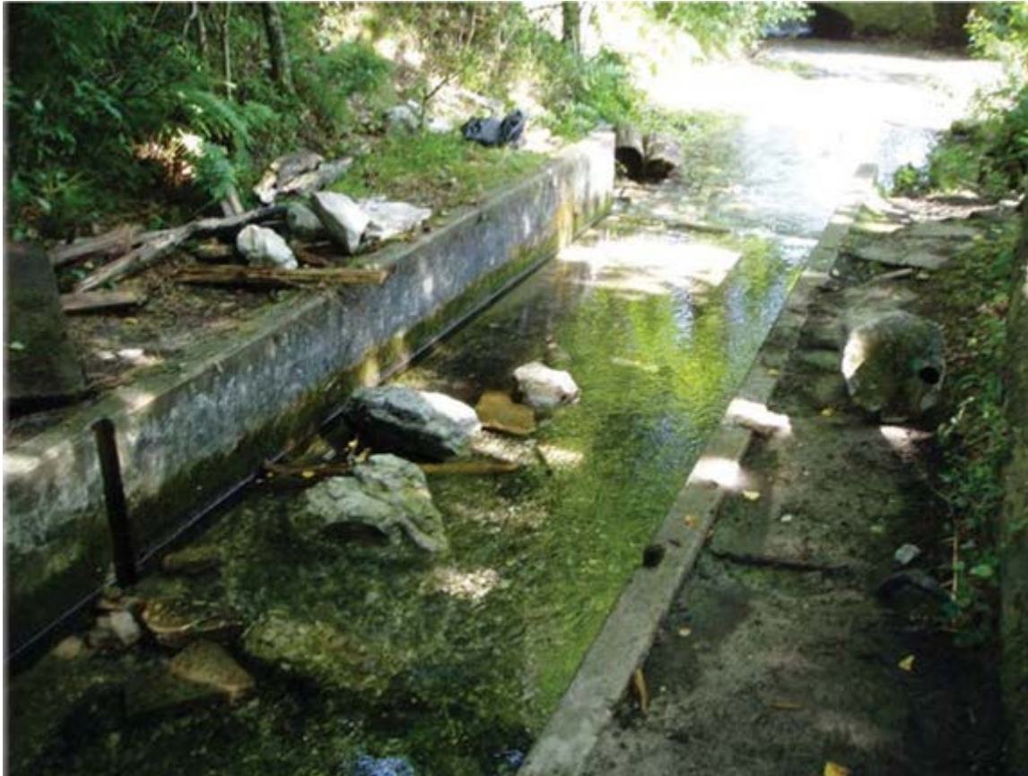
Bild 2 Steine im Messprofil des Pegels Pivitsheide / Rethlagerbach
