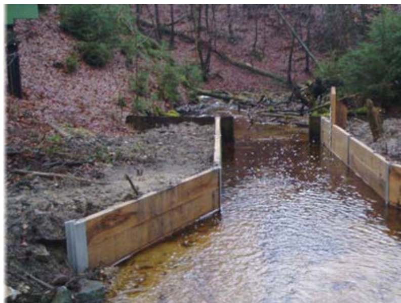
Bild 4 Pegelanlage Donoper Teich /Hasselbach nach dem Umbau
