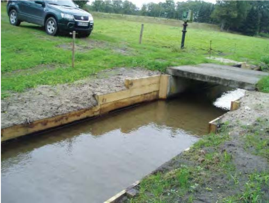
Bild 5 Pegel Staumühle / Haustenbach nach Beendigung der Umbaumaßnahmen
