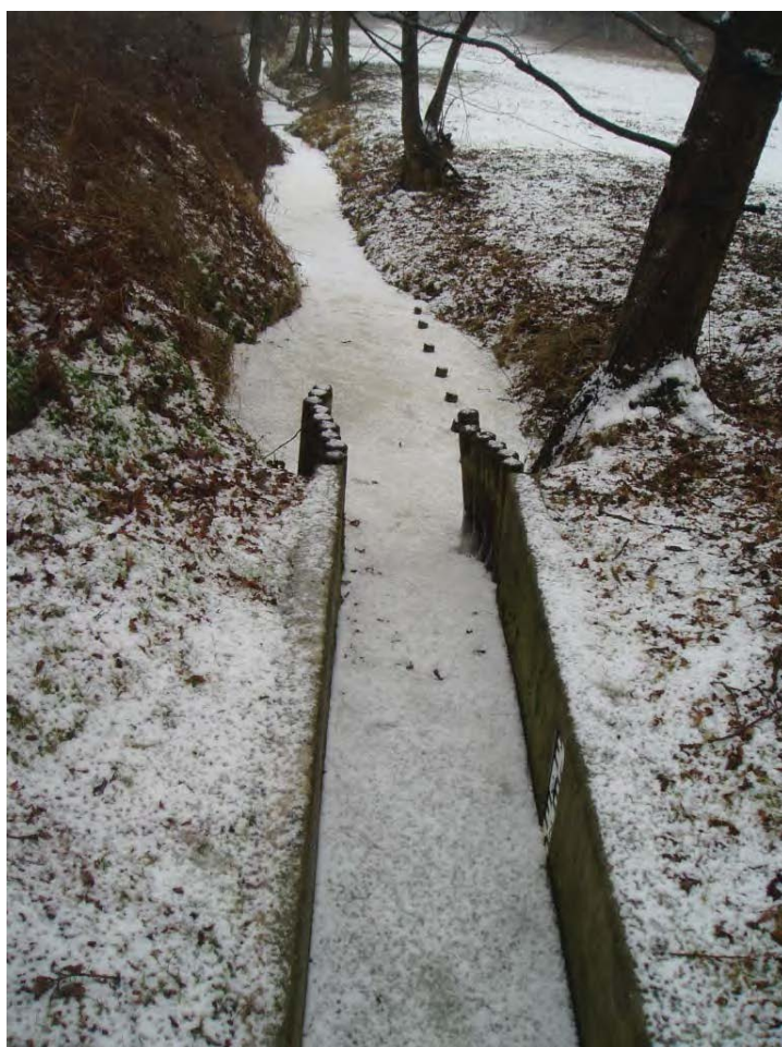
Bild 7 Komplett vereiste Messrinne am Pegel Mittweg / Rahmkebach im Februar
