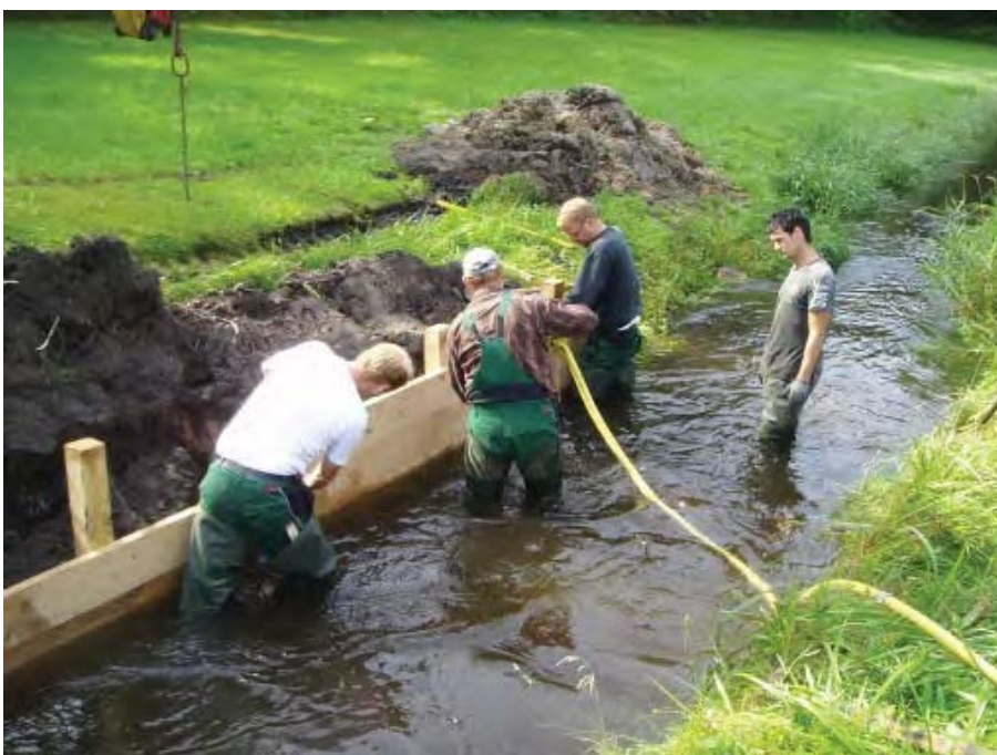
Bild 4 Mitarbeiter der Baufirma beim Setzen der Flügelwände
