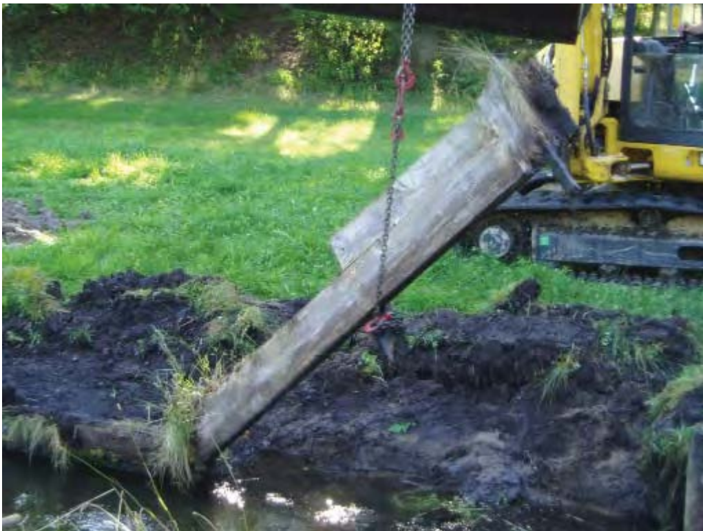
Bild 2 Entfernen der maroden Flügelwände am Pegel Staumühle Hausenbach
