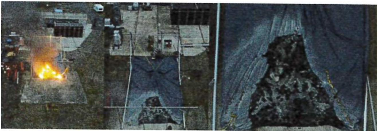
**Bild 11** Aufnahmen des Schadensbildes nach dem Abbrand der Biogasfolie.
