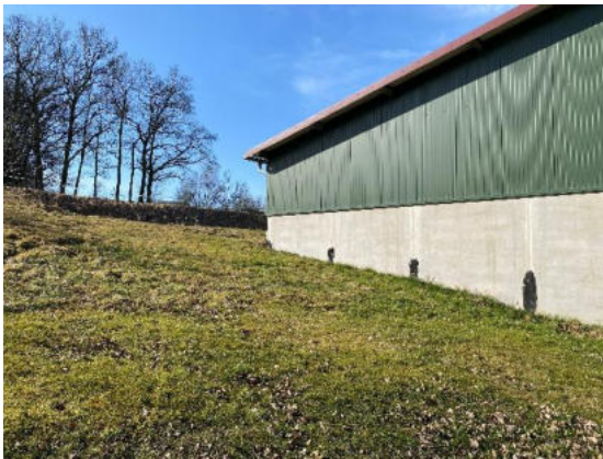
Bild 2: Blick auf den Bereich, wo der Pufferspeicher gebaut werden soll
