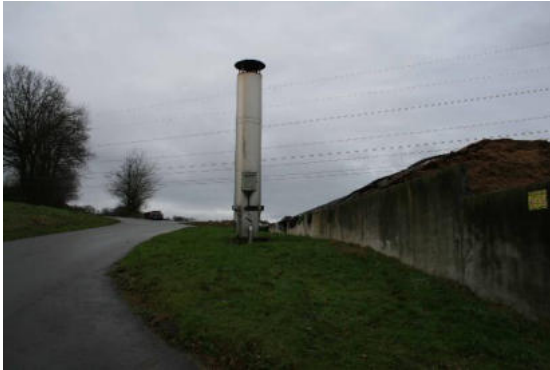
Bild 1: Blick auf den Bereich, wo das neue BHKW gebaut werden soll
