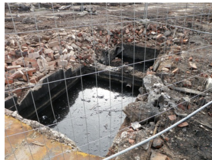
Abbildung 2: Offengelegte Teergrube während des Rückbaues
