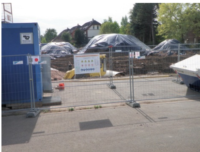
Abbildung 3: Belasteter Aushub steht unter Folien gesichert zur Abfuhr bereit.
