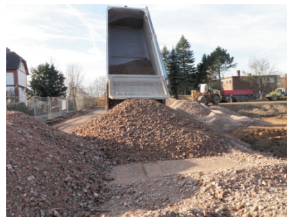
Abbildung 6: Anlieferung von externem Recyclingmaterial zur Wiederverfüllung
