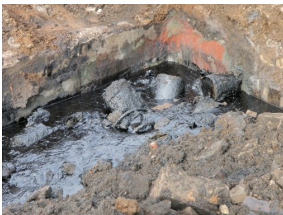
Abbildung 5: Ständig werden neue Teergruben angetroffen
