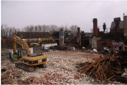
Abbildung 1: Beginn der Abbrucharbeiten
