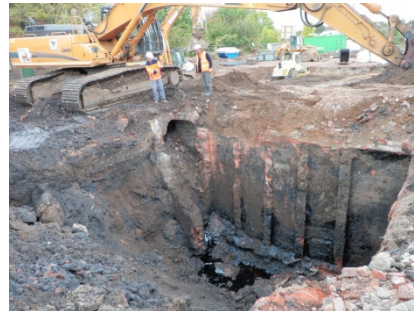
Abbildung 4: Aushub einer alten 6 Meter tiefen Teergrube
