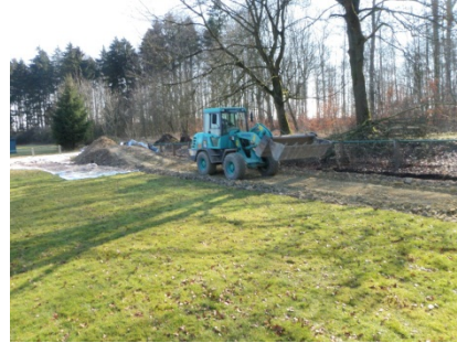
Abbildung 8: Transport des Kieselrot-Materiales zur Übergabestation mittels Radlader
