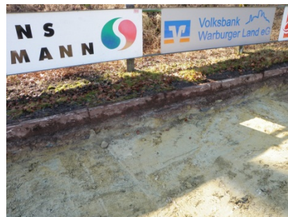
Abbildung 6: Randeinfassung Laufbahn mittlerer Bereich nach Entfernung des Kieselrot-Materiales
