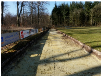
Abbildung 5: Laufbahn westlicher Bereich; nach Aufnahme des Kieselrot-Belages
