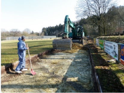
Abbildung 7: Abziehen der Kieselrot-Tragschicht mit Hilfe eines Löffelbaggers
