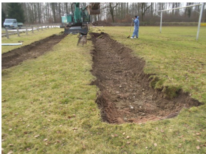
Abbildung 11: Aufnahme der Kieselrot-Materialien; Weitsprunganlaufbahnen 1 und 2
