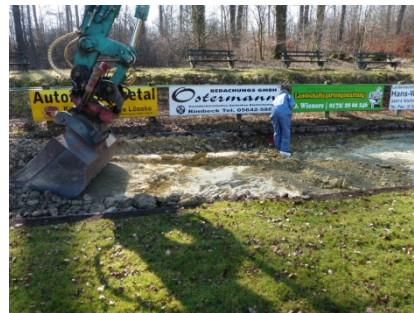
Abbildung 4: Nacharbeiten per Schaufel; Laufbahn Randbereich
