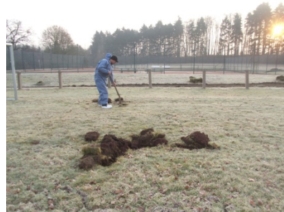
Abbildung 10: Erkundung weiterer Sanierungsteilflächen (zwei Weitsprunganlaufbahnen)
