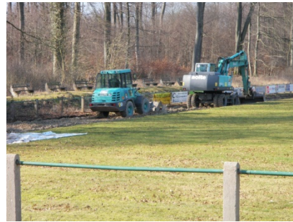
Abbildung 2: Sanierungsarbeiten; Laufbahn mittlerer Bereich
