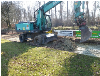
Abbildung 3: Aufnahme der Kieselrot-Tragschicht; Laufbahn mittlerer Bereich
