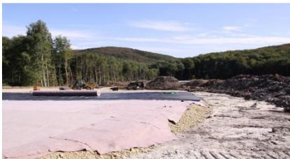
Abbildung 6: Einbau der Oberflächenabdichtung
