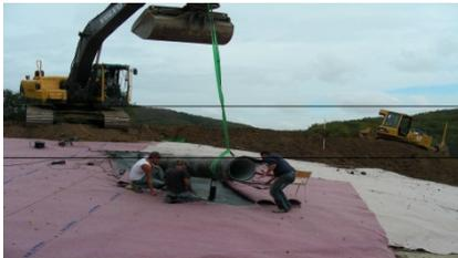
Abbildung 8: Einbau der Bodenabdeckung
