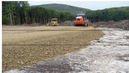
Abbildung 5: Einbau der Oberflächenabdichtung
