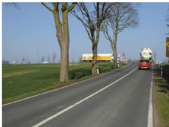
Abbildung 10: Die L754/ Bürener Straße. Beidseits würde das neue Gewerbegebiet entstehen. Es gibt hier keinen Fuß- und Radweg. Zwei Lastwagen können sich nur knapp und im Schritttempo begegnen.
