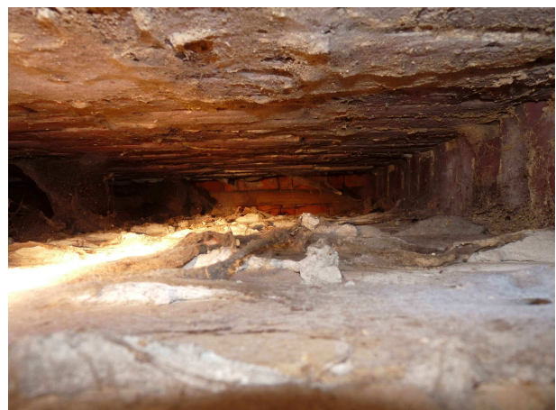
Abbildung 3.13: Blick nach oben in den Hohlraum zwischen dem zweischaligen Mauerwerk.
