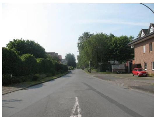
Abb. 17 Knotenpunkt Ostring/Rietberger Straße. Blick nach Süden in den Ostring (ca. Bau-km 1+170).
