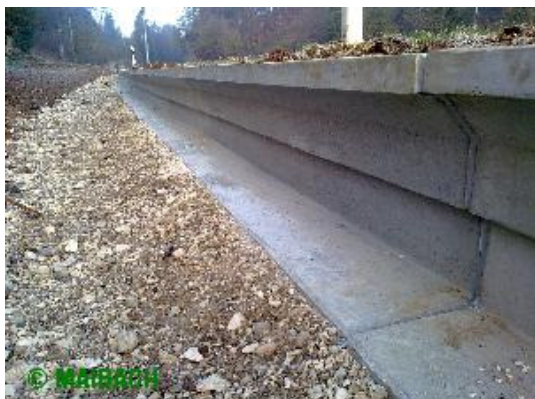
Abb. 27 Beispiel für Amphibienleiteinrichtung aus Beton.
