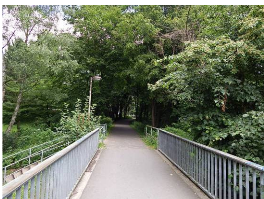
Abb. 12 Blick auf die bestehende Rad- und Fußgängerbrücke über die Ems (ca. Bau-km 0+870).
