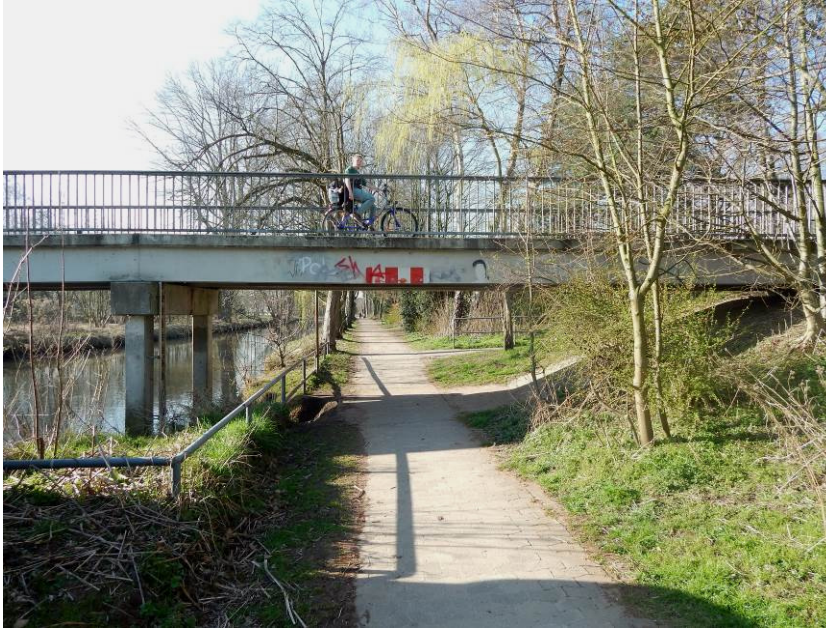
Abb. 33 Vorhandene Rad- und Fußwegbrücke.
