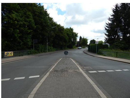
Abb. 3 Blick auf den Südring und den Gehölzbestand (links) im Bereich der geplanten Trasse (Bau-km 0+000).
