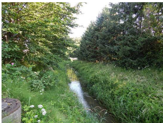
Abb. 23 Blick in nördliche Richtung auf den Hamelbach und die Brücke im Untersuchungsgebiet.
