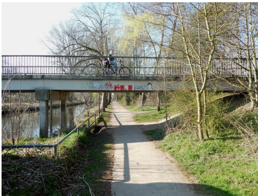
Abb. 33 Vorhandene Rad- und Fußwegbrücke.
