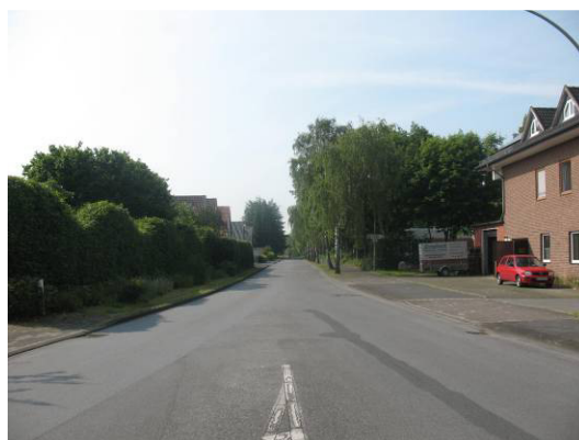
Abb. 17 Knotenpunkt Ostring/Rietberger Straße. Blick nach Süden in den Ostring (ca. Bau-km 1+170).
