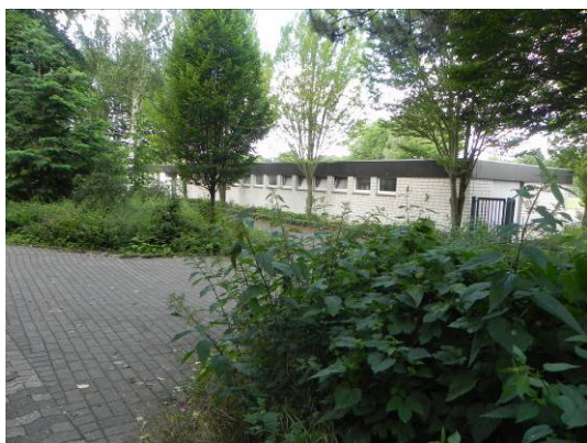
Abb. 36 Gebäude am Sportplatz.
