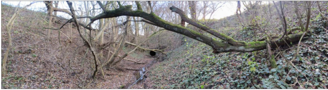
Abbildung 38: Tief eingekerbter Maibach im Bereich der vorgesehenen Querungshilfe.
