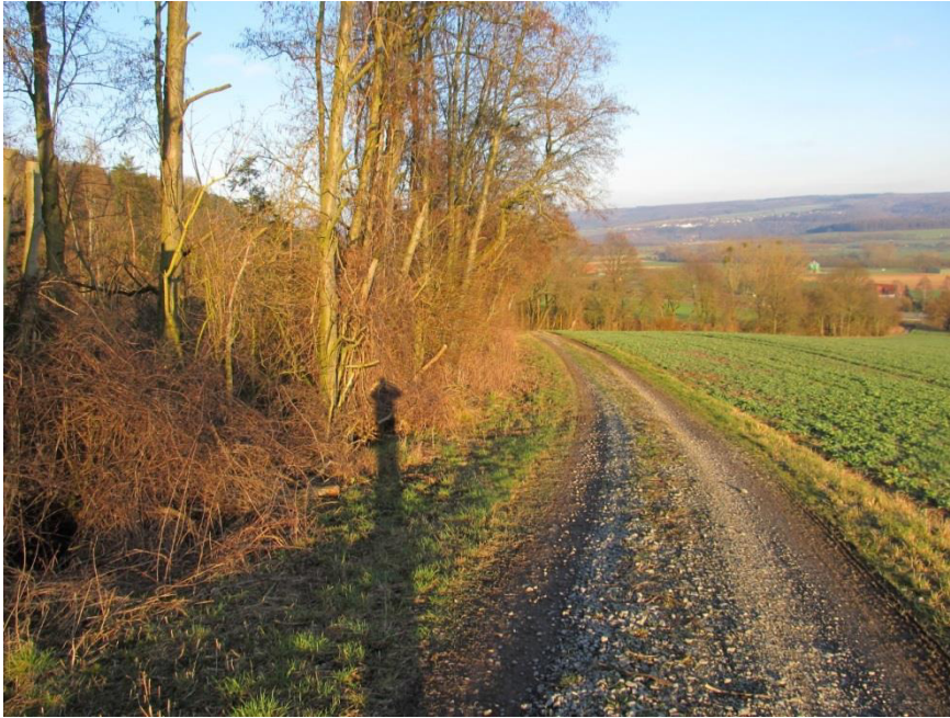
Abbildung 49: Umzustrukturierender Wirtschaftsweg unterhalb des Waldhangbereiches von 1.19. Der neue Wirtschaftsweg ist auf die angrenzende Ackerfläche zu verlegen.
