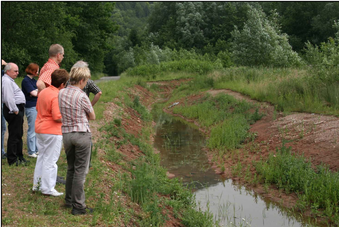
Abb. 3: Neu angelegter Graben zur Beruhigung des Abgrabungsgewässers (M6) (Aufnahmedatum 20.06.2006)
