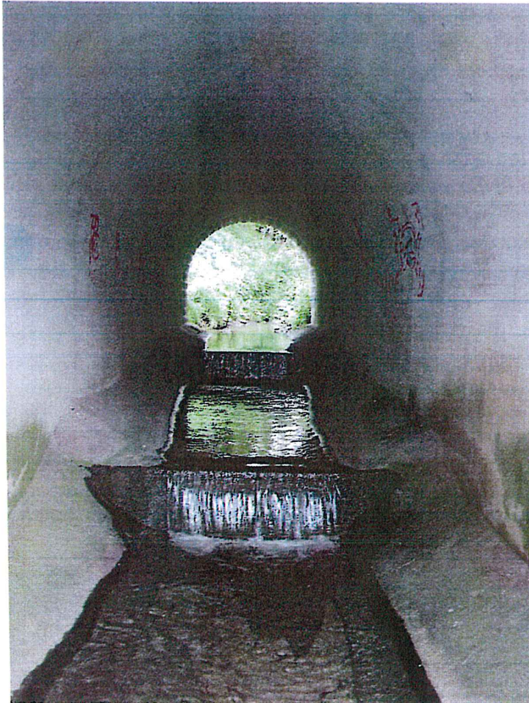
Abb. 4: Unterer Durchlass mit Abstürzen
