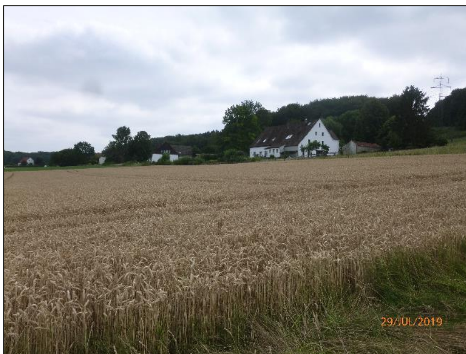
Abbildung 62: Außenbereich „Heidbreite 3“ mit Blick von der Freileitungstrasse auf das Wohngebäude und den Gartenbereich in Richtung Südosten
