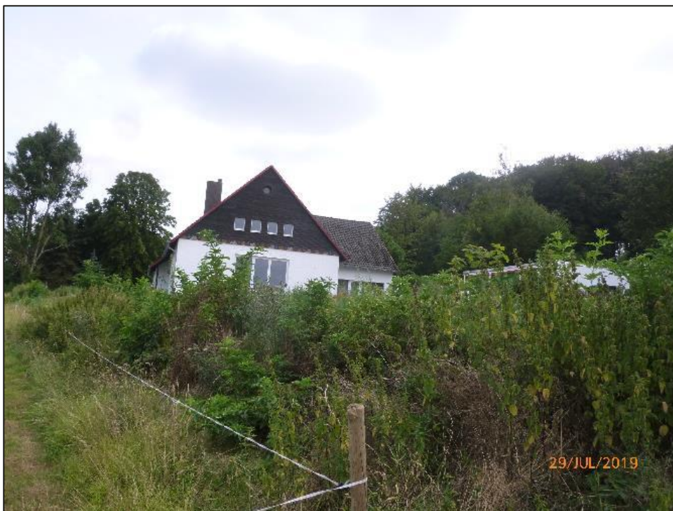
Abbildung 65: Außenbereich „Heidbreite 4“ mit Blick von der Freileitungstrasse auf das Wohnhaus in Richtung Südosten
