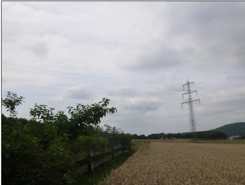
Abbildung 63: Außenbereich „Heidbreite 3“ mit Blick in Richtung Westen mit Sicht vom Grundstück auf die Freileitung in Richtung Nordwesten
