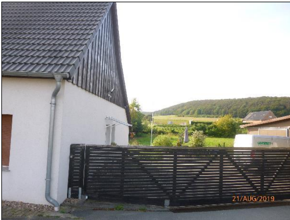
Abbildung 36: Außenbereich „Osnabrücker Straße 86“ mit Blick auf das Wohngebäude in Richtung Westen
