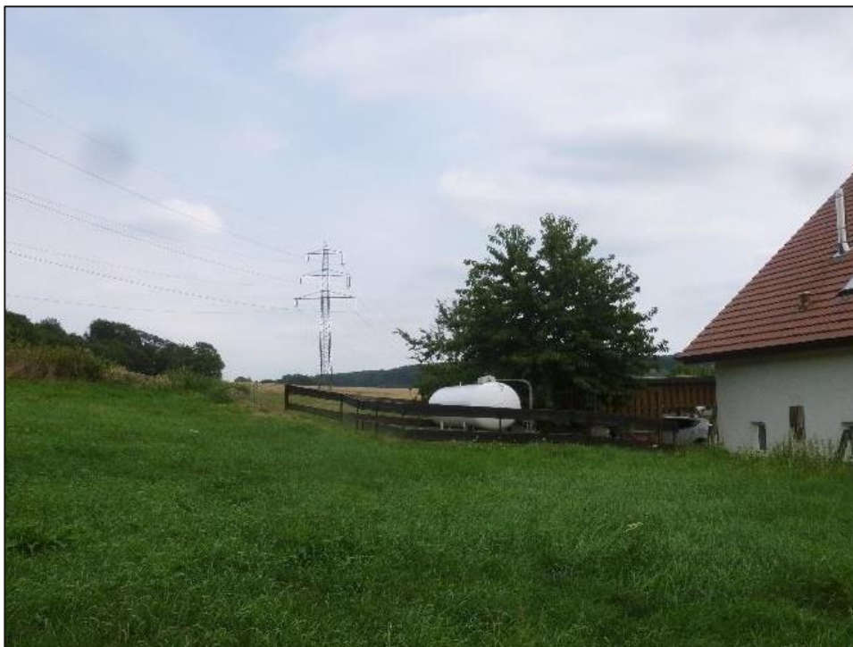
Abbildung 74: Außenbereich „Sundernstraße 47“ mit Blick auf die Freileitungstrasse in Richtung Südosten
