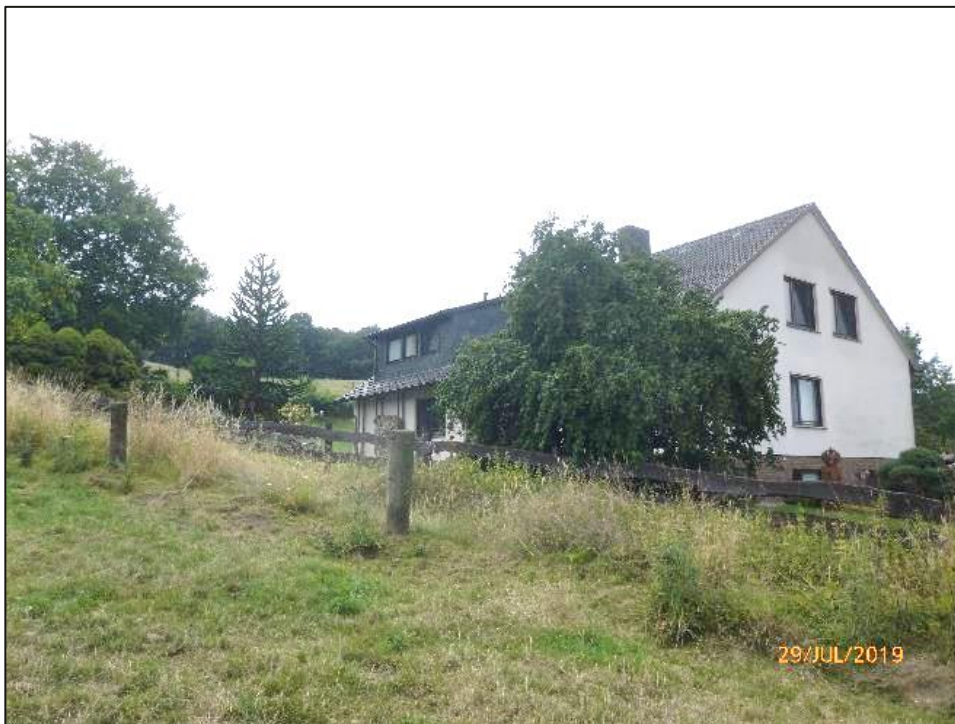
Abbildung 61: Außenbereich „Heidbreite 2“ mit Blick von der Freileitungstrasse auf das Wohnhaus in Richtung Südwesten
