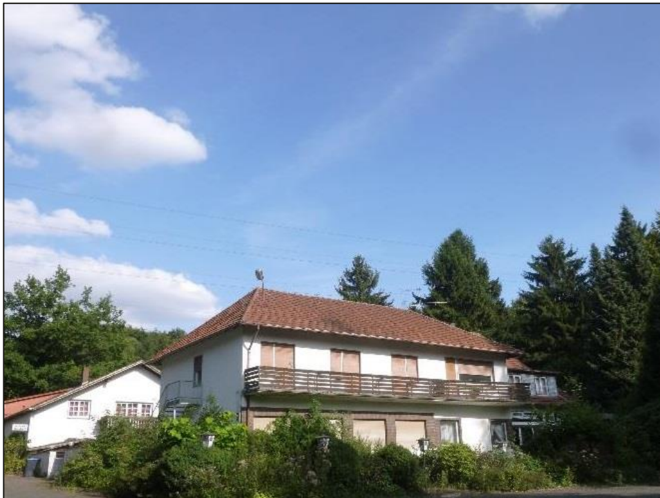
Abbildung 45: Außenbereich „Hesseltal 10“ mit Blick nach Nordosten auf das Wohngebäude
