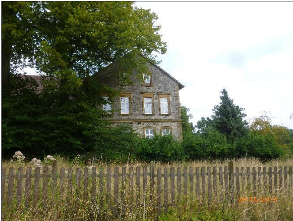
Abbildung 58: Außenbereich „Wichlinghausen 1“ mit Blick von der Freileitungstrasse Richtung Wohngebäude nach Norden
