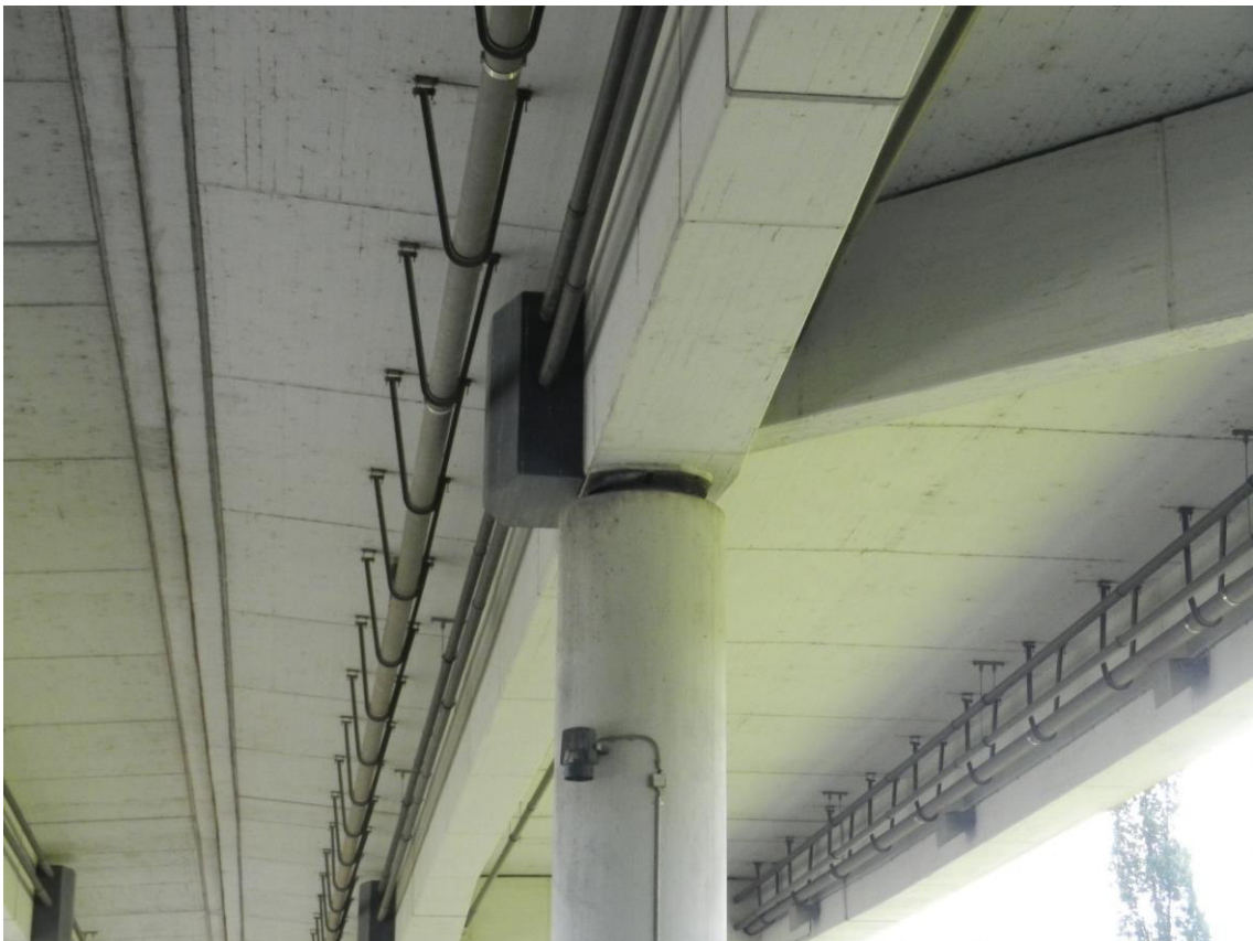
Abbildung 5 Widerlager an Brückenpfeiler (Brücke Nr. 13, Schönwasserparkbrücke)
