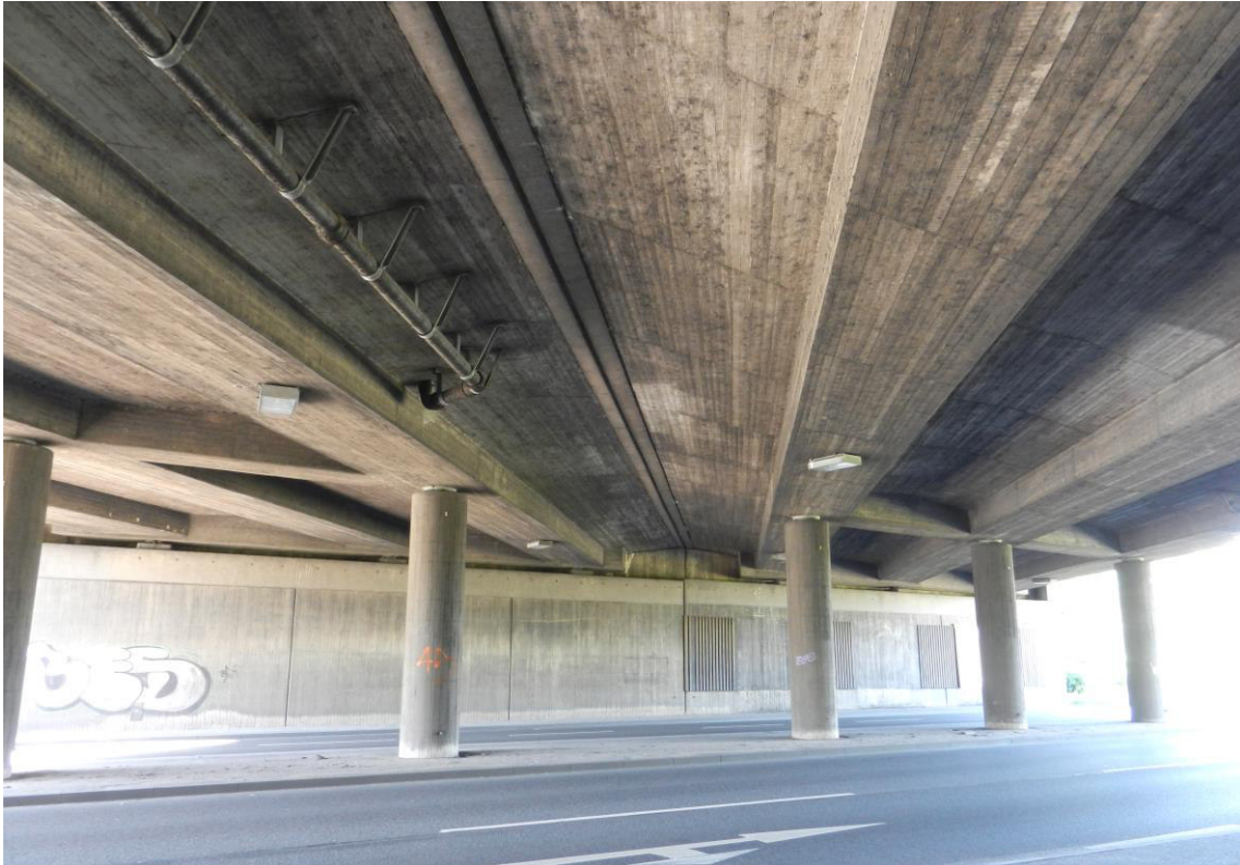
Abbildung 9 Brücke über Berliner Straße (Brücke Nr. 11); Blick auf Nordwand
