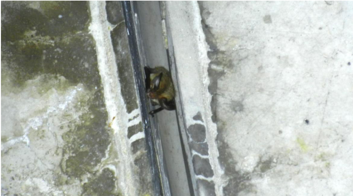
Abbildung 2 Braunes Langohr in Dehnungsfuge des Bauwerks Nr. 12 (Bauwerk Hafenbahn/Zuwegung Kleingartengelände)
