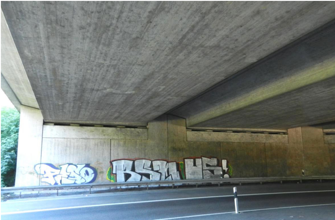
Abbildung 8 Brücke über südliche Ausfahrrampe der Anschlussstelle Gartenstadt (Brücke Nr. 3) mit zwei der zum Schwärmen genutzten Strukturen zwischen den Widerlagern (Südseite: zentrale und östliche Struktur, vgl. Abbildung 14 und Abbildung 15)
