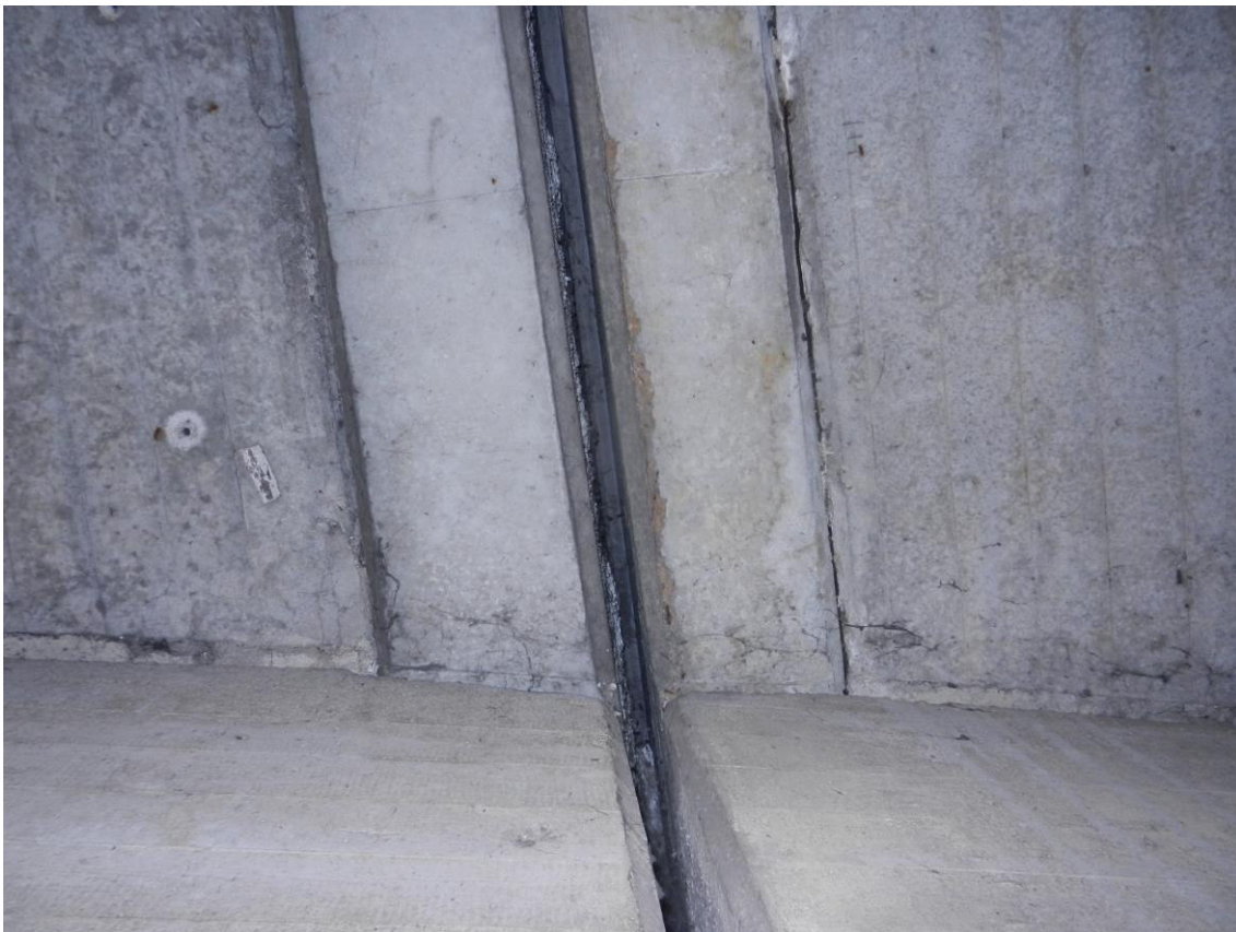
Abbildung 3 Dehnungsfuge zwischen Fahrrichtungen der A 57 der Brücke Nr. 3 (südliche Ausfahrrampe in der AS KR-Gartenstadt)
