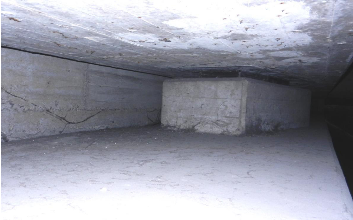
Abbildung 4 Widerlager der Brücke Nr. 3 (südliche Ausfahrrampe in der AS KR-Gartenstadt)
