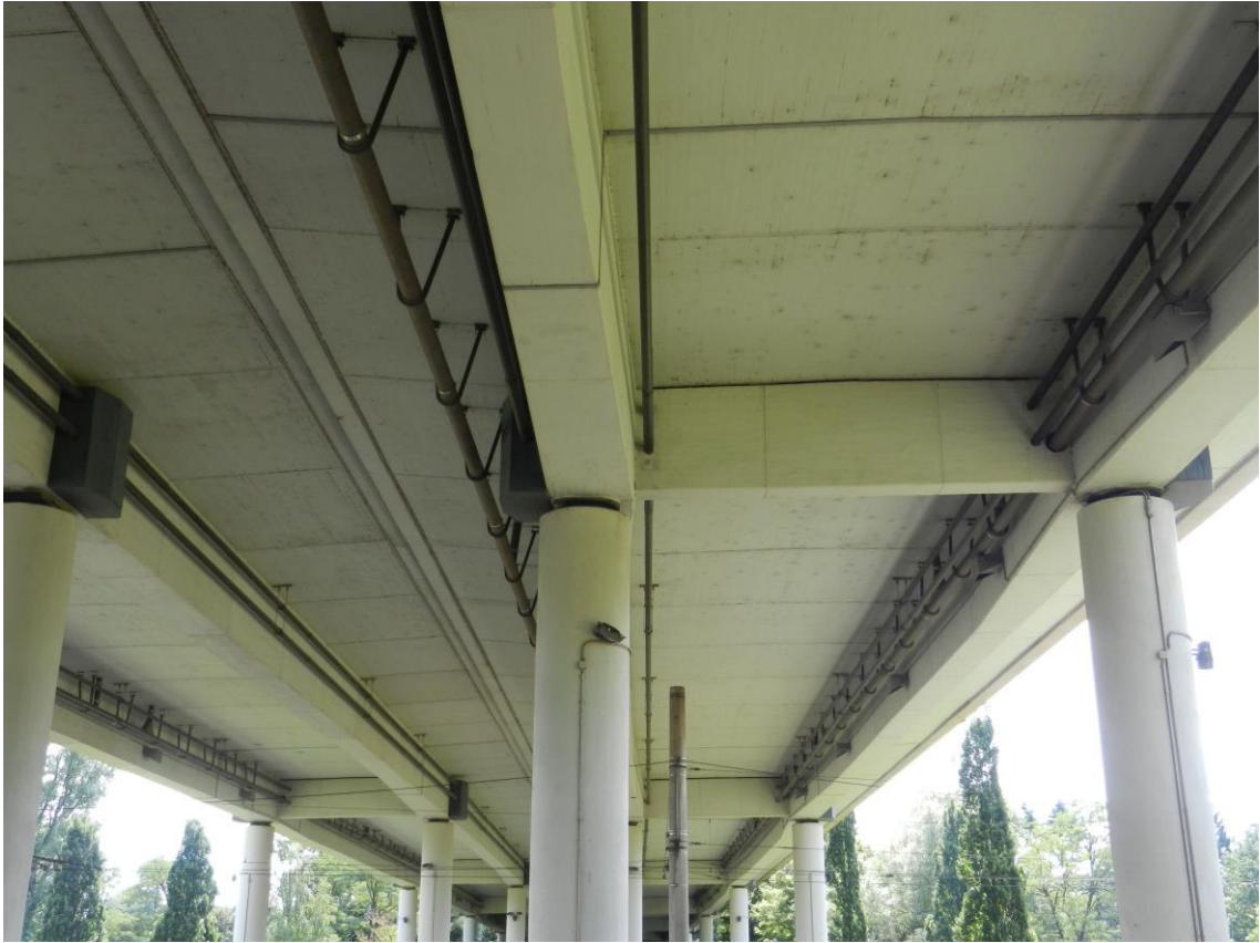
Abbildung 10 Schönwasserparkbrücke (Brücke Nr. 13); Übersicht Nordteil
