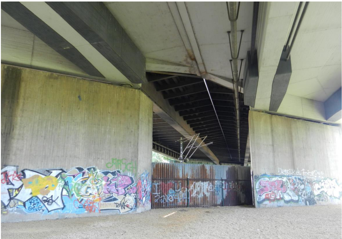
Abbildung 11 Schönwasserparkbrücke (Brücke Nr. 13); Übersicht Südteil
