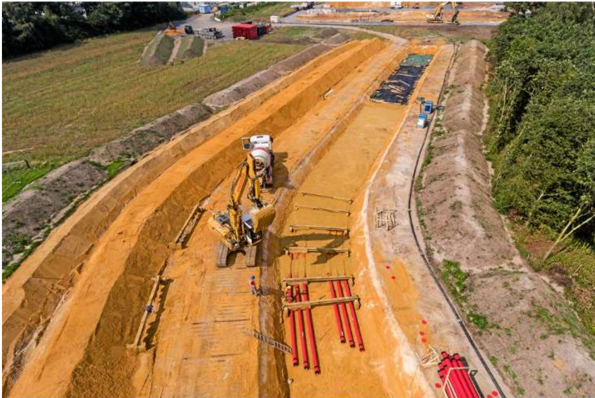
Abbildung 1: Bearbeitungsabschnitt mit seitlicher Lagerung der Bodenhorizonte innerhalb des Arbeitsstreifens
