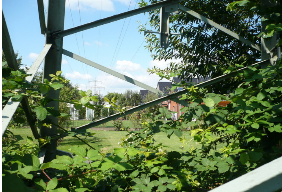
Abbildung 6: Trassenverlauf im Siedlungsbereich - Überspannung von Hausgärten (Blick von Mast 15 nach Westen)
