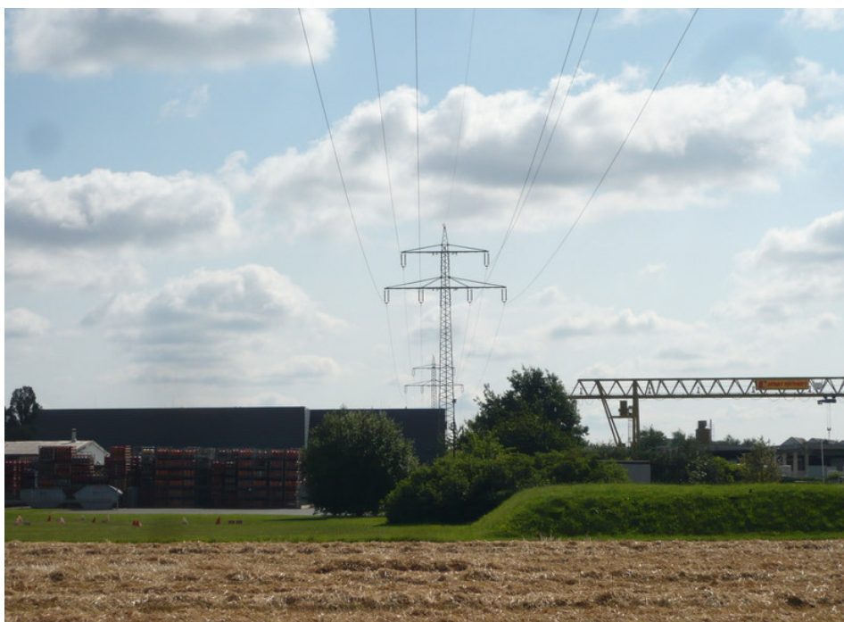
Abbildung 5: Trassenverlauf im Gewerbegebiet zwischen Harkorddamm und Mitteldamm (Mast 12, Blickrichtung nach Osten)
