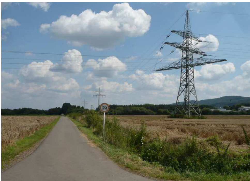
Abbildung 3: Mast 68 der 110-kV-Leitung Rehme - Meißen. Die 110-kV-Leitung Uphausen - Minden/West schließt an der Quertraverse an.
