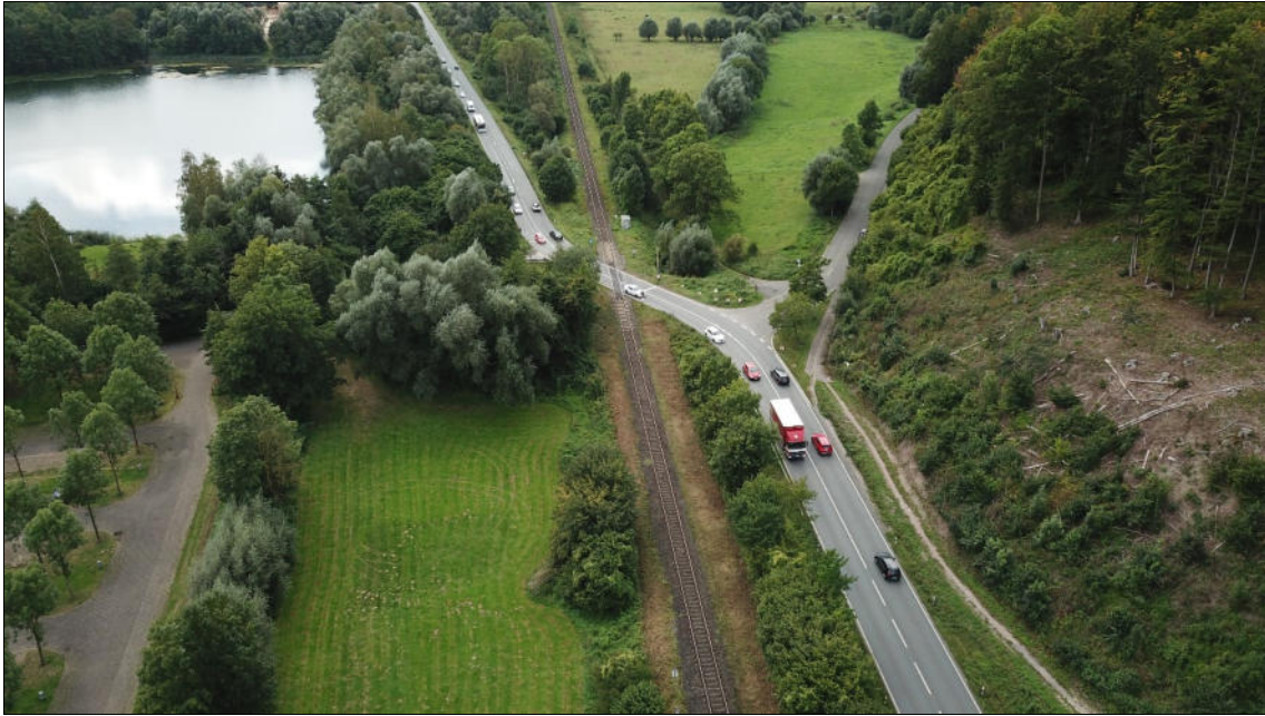
Abb. 3: Foto Flugroute FR1 und FR2 - Fahrtrichtung Paderborn (September 2020)
