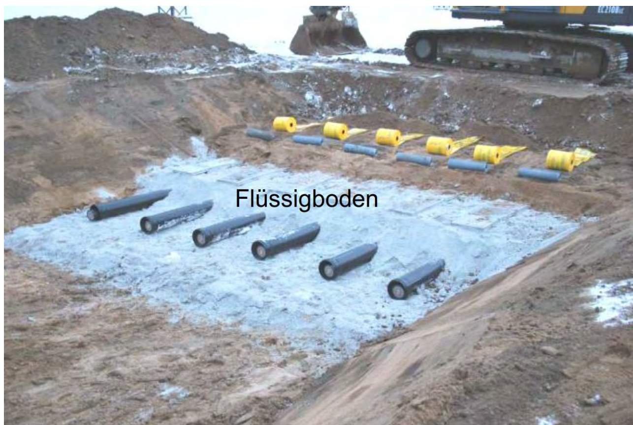
Abbildung 15: Detailaufnahme des zeitweise fließfähigen selbstverdichtenden Verfüllbaustoff (Quelle Amprion)
