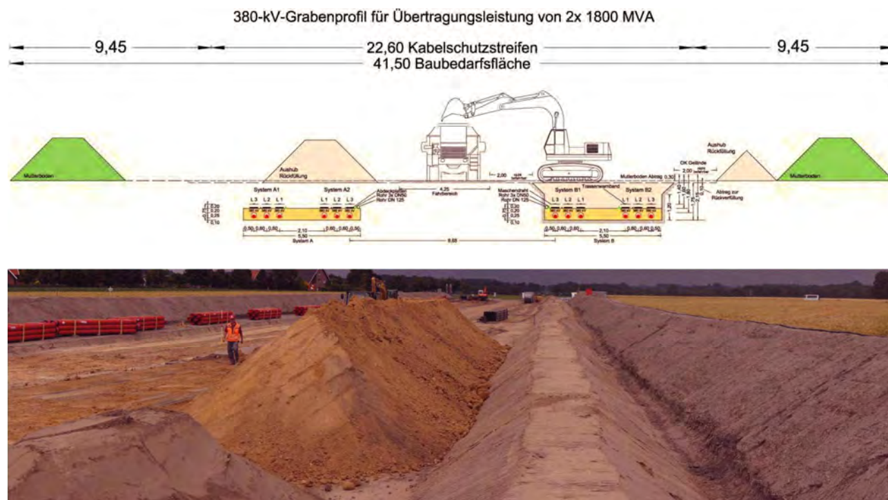
Abbildung 11: Regelprofil Bodenaushub und Anlegen von seitlichen Mieten (unten Beispiel Raesfeld)
