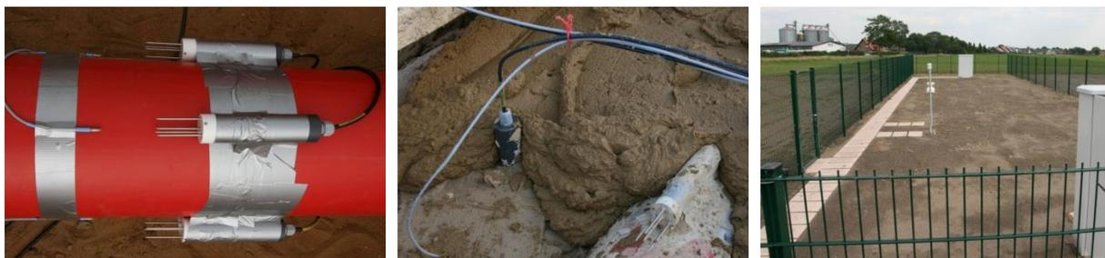
**Abb. 41: Instrumentierung am Schutzrohr, Verguss mit ZFSV und Sensorfeld**
