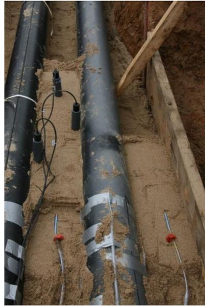
**Abb. 22: Instrumentierung der Kabelanlage zur Temperatur- und Feuchtemessung**
