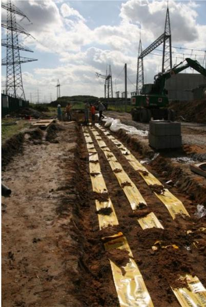
**Abb. 21: Kabeltrasse unmittelbar vor der Fertigstellung**
