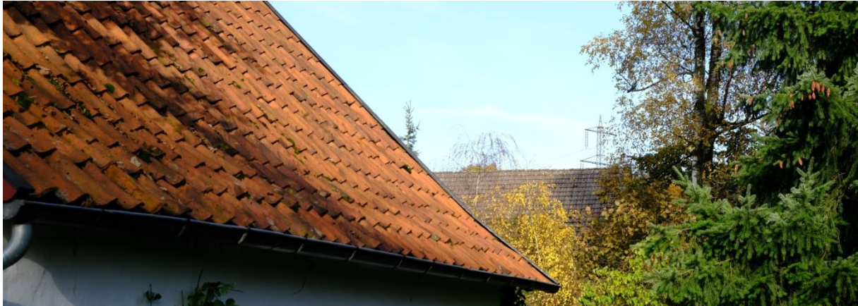
Abb. 8: Kroe Künstlerhaus (links) und Mast der Bestandstrasse
