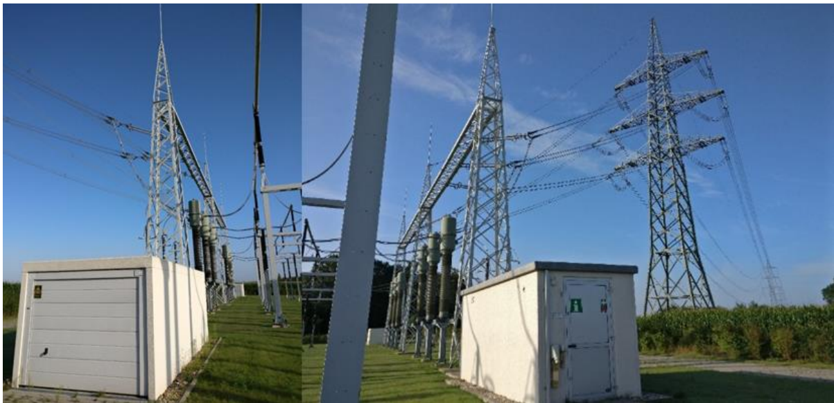
Abbildung 28: Lagerraum (links) und Technikraum (rechts) einer KÜS
