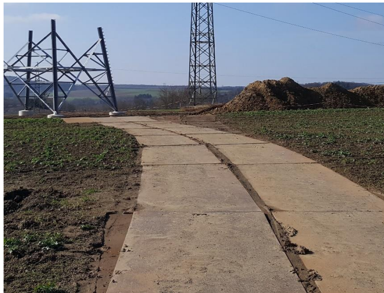
Abbildung 6: Temporäre Zuwegung über Stahlplatten
