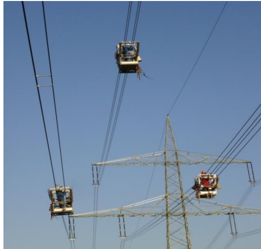
Abbildung 15: Montage der Feldbündelabstandshalter mit Fahrwagen
