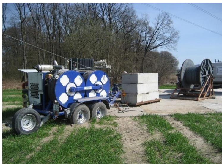
Abbildung 14: Windenplatz eines 4er-Bündel-Seilzugs
