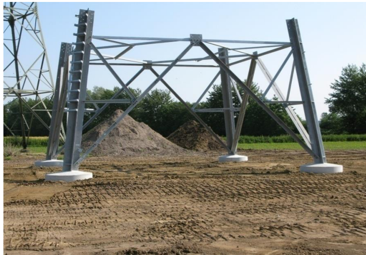
Abbildung 10: Montierter Mastfuß
