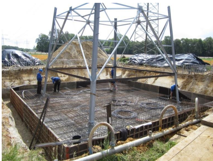
Abbildung 8: Montage der Fundamentbewehrung für ein Plattenfundament
