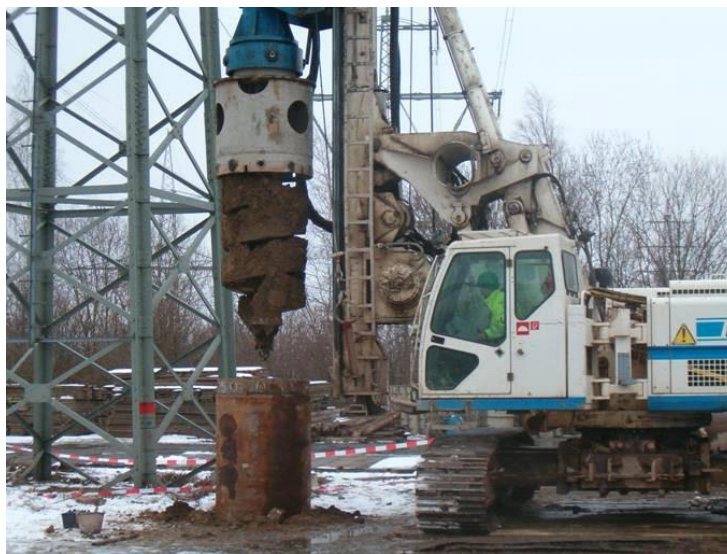
Abbildung 9: Bohrung für einen Bohrpfahl
