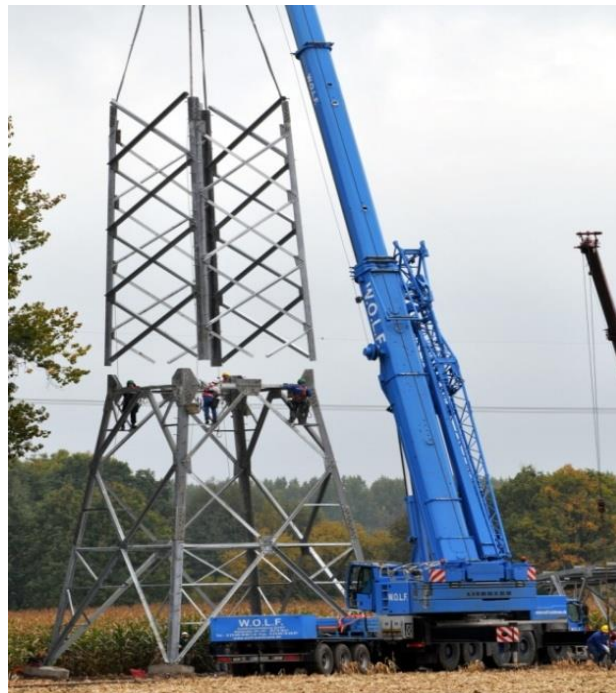
Abbildung 11: Mastmontage (Stocken)
