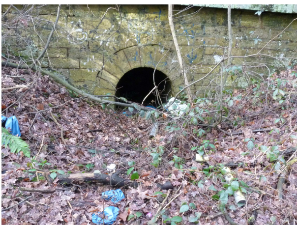
Abbildung 3.3: Östlicher Eingang der Bahnunterführung 3.
