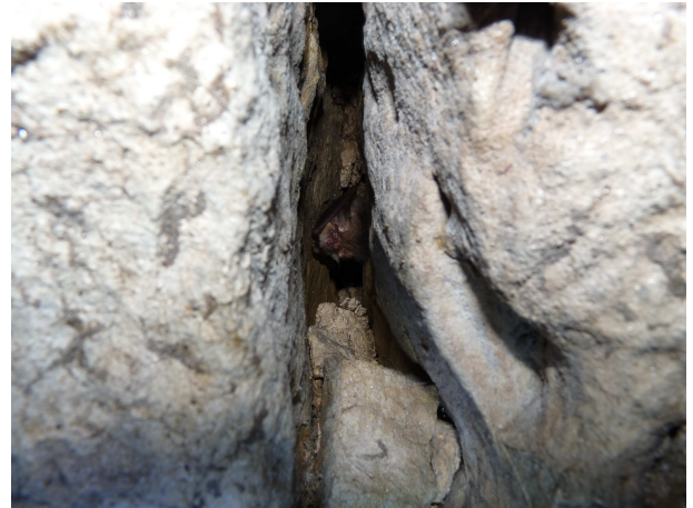
Abbildung 3.2: Braunes Langohr in Deckenfugen der Bahnunterführung 1.
