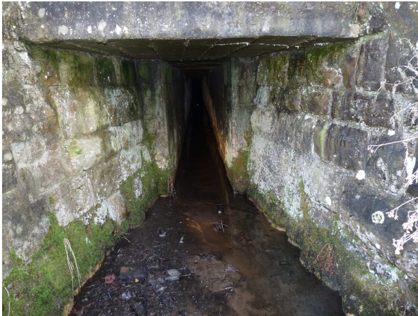
Abbildung 3.1: Eingangsbereich der Bahnunterführung 1.
